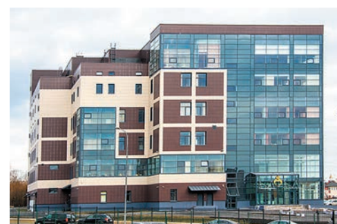
Центр доклинических и трансляционных исследований Центра Алмазова
