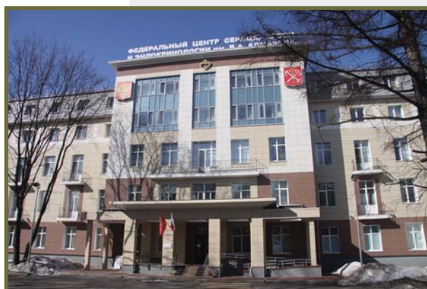
Здание реабилитационного корпуса после реконструкции пр. Пархоменко, дом 15, лит. А
