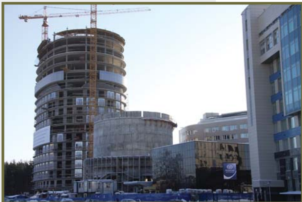
Строительство лечебно-реабилитационного корпуса № 2. ул. Аккуратова, д. 2.
