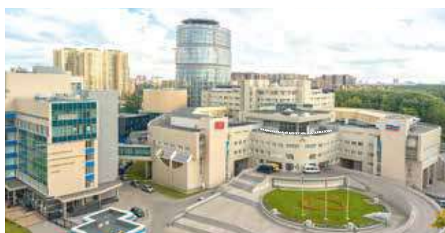
Главный клинический комплекс и Перинатальный центр (ул. Аккуратова, д. 2)
