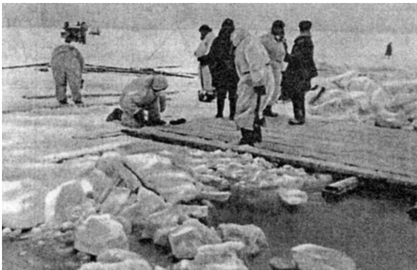
Прокладка трубопровода по дну Ладожского озера, осень 1942 год
