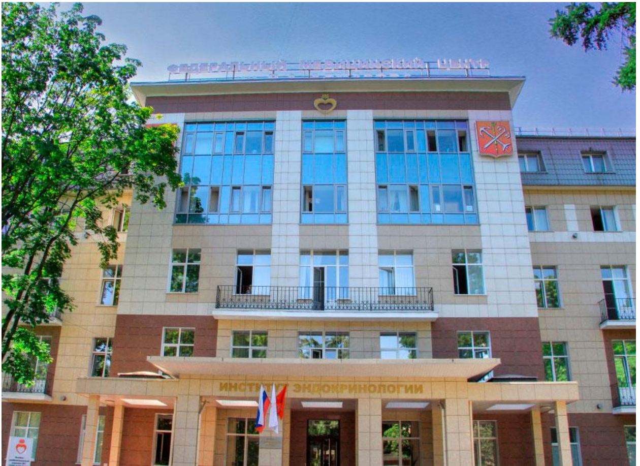
Здание лечебно-реабилитационного корпуса после реконструкции
