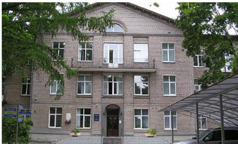
Здание лечебно-реабилитационного корпуса до реконструкции
