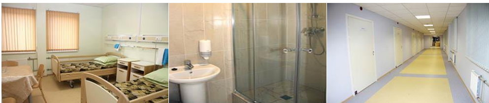
Палата после реконструкции Палата после реконструкции Холл после реконструкции
