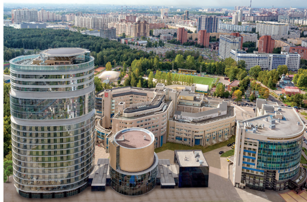
Новое 21-этажное здание имеет панорамное остекление, что позволяет использовать для освещения помещений естественный солнечный свет.
