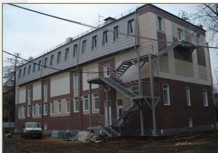
Реконструкция здания ЛРК-1, лит. Б (пр. Пархоменко, д. 15)
