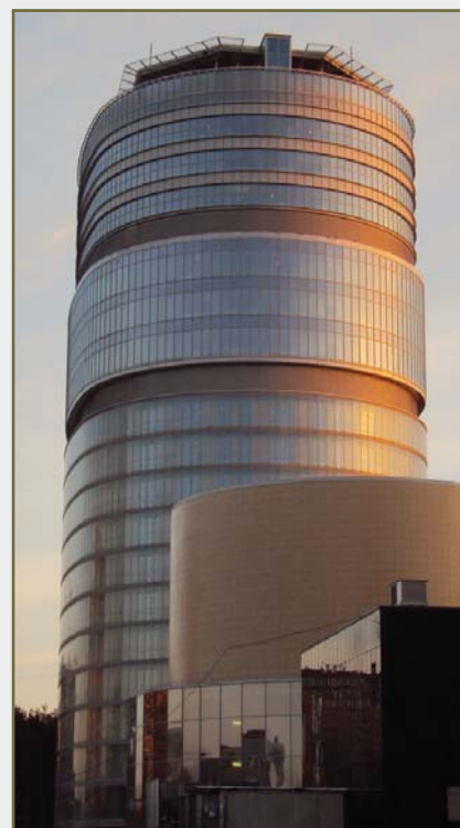
Здание лечебно-реабилитационного комплекса № 2 (ул. Аккуратова, д. 2)
