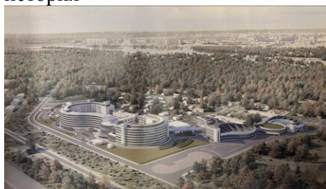
строится новое здание РНХИ
