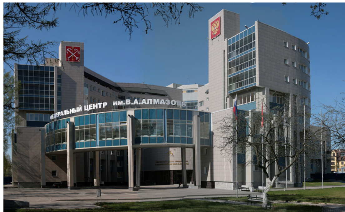
Клинико-поликлинический корпус по адресу: ул. Аккуратова, д. 2, лит. А
