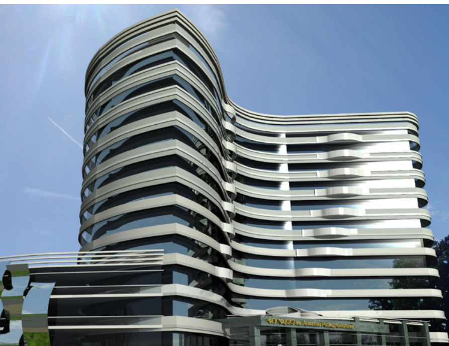
Лечебно-реабилитационный комплекс для Перинатального центра (ЛРК-3) по адресу: г. Санкт-Петербург, Коломяжский проспект (на пересечении с ул. Королева). Завершение работ планируется в 4 квартале 2016 г.
