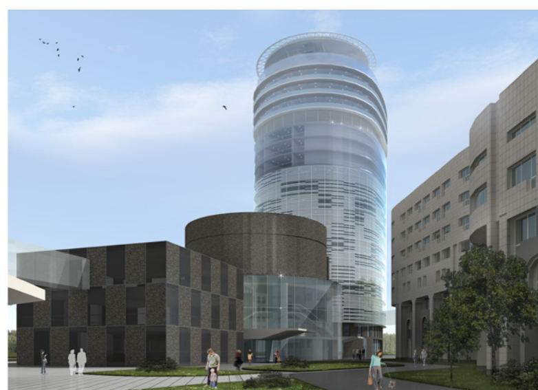
Три здания, входящие в состав лечебно-реабилитационного комплекса (ЛРК-2)
