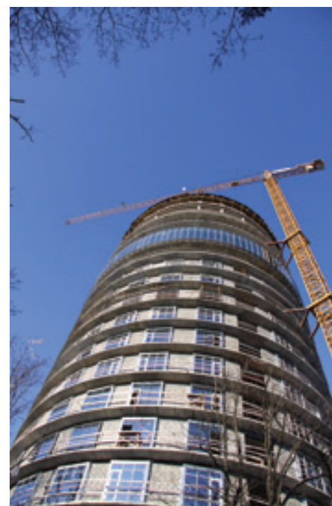
Лечебно-реабилитационный комплекс (ЛРК-2) по адресу: Санкт-Петербург, ул. Аккуратова, дом 2. Завершение работ планируется в 4 квартале 2014 г.
